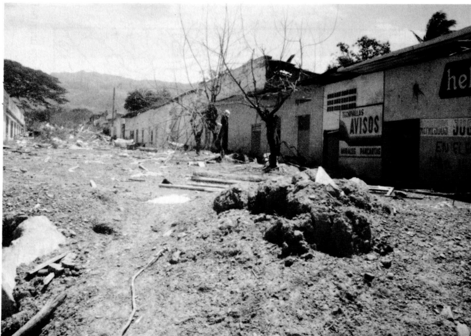
Foto No. 5. Aspecto de una calle inclinada, parcialmente invadida por el lodo. Note cómo las edificaciones del fondo, de mayor cota, quedaron intactas.
