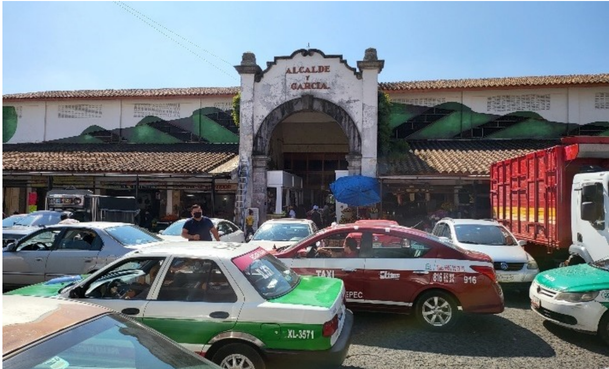
Figura 2. Mercado Alcalde y García desde la calle Miguel Arrieta, costado sur
