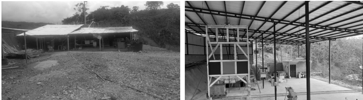
Figura 1. Comparativo entre el estado de tecnificación de la UPM principal de Mineros La María S.A.S. en 2022 (Izquierda) y su estado en 2024 (Derecha)
