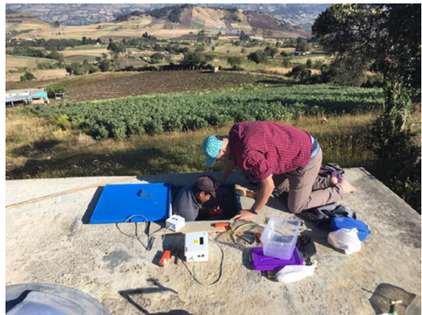
Figura 4. Instalación del equipo de medición en el tanque de Agua del Acueducto. En la foto: (Izquierda) Aquileo Marente Rodríguez, operario del Asoporquera I, (derecha) Juan Diego Escobar Mejía. Autor: Alejandro Pulido (2020)
