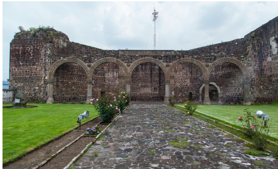
Figura 1. Vista general de la capilla abierta de Tlalmanalco
