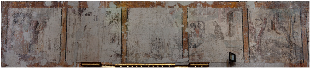
Figura 5. Escenas localizadas en el muro del evangelio del presbiterio de la iglesia de Tlalmanalco
