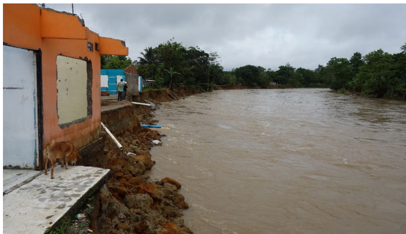
Figura 6. Socavación de las orillas del río Caquetá en el barrio Simón Bolívar
