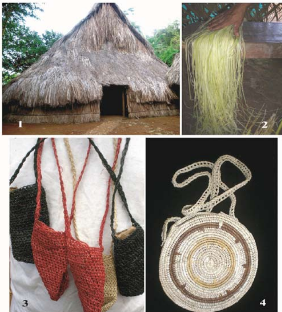
Fig. 1.1 El techo fue construido con hojas secas de kinena o canangucha ( Mauritia flexuosa ) y komaiña ( Oenocarpus bataua ); las vigas de sustento con troncos secos de granadillo ( Brosimum sp.)
