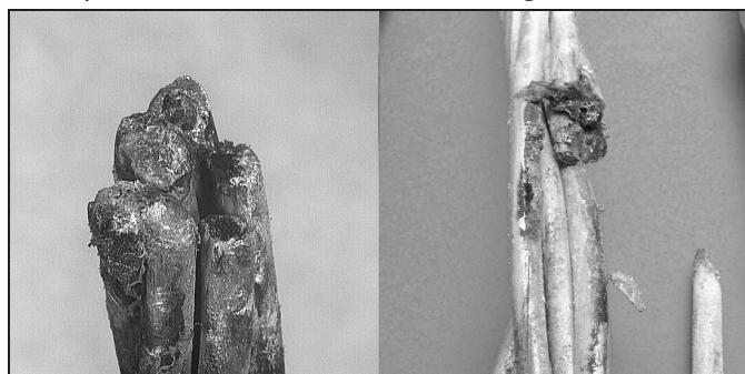
Figura 12. Superficies de fractura por descarga en cables de conducción eléctrica de media tensión, cuyos arcos se iniciaron en grietas de fatiga inducidas por el viento y que nuclearon en picaduras por corrosión
