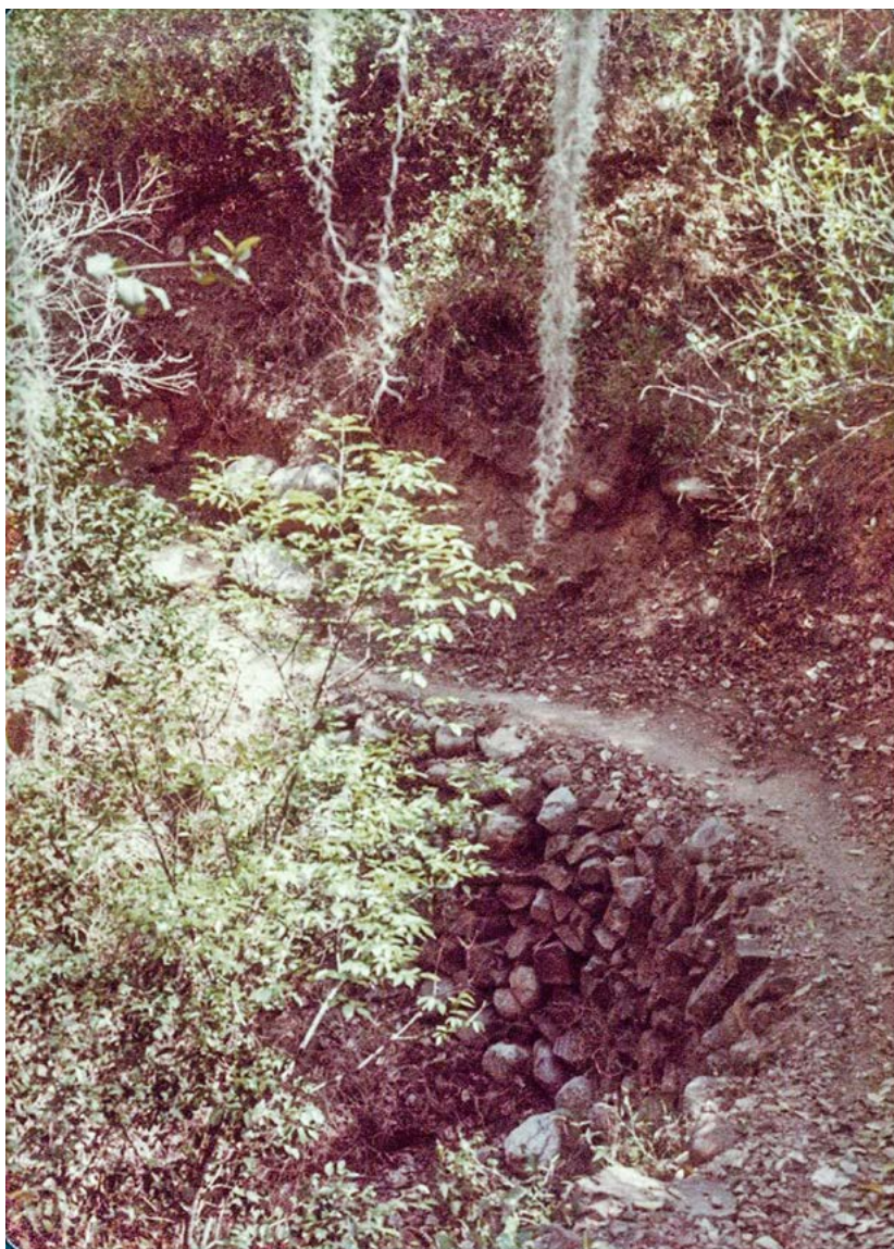
Figura 9. Ingeniería lítica kogi: muro de contención
