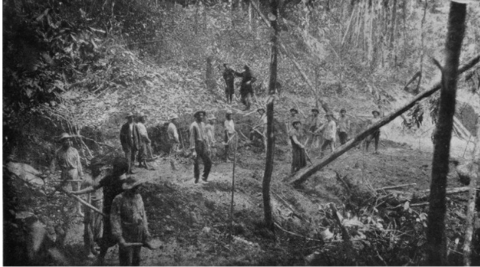
Figura 23. Misionero dirigiendo los trabajos de la apertura de un camino
