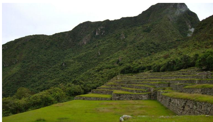
Sector agrícola. Estas terrazas eran para cultivo. Estaban construidas en tres capas: piedra, tierra y luego la tierra útil (fértil) para cultivar, traída de diversos sitios (diferentes alturas).
