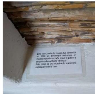
**Fotografías 1 y 2.** Museo MAJA, Jericó (Antioquia), muestra de material de construcción de las primeras viviendas del municipio. Bareque: estructura de madera forrada en caña brava o guadua y empañetada con tierra y boñiga.
