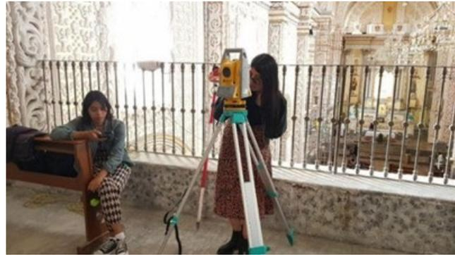
Figura 33. Levantamiento topográfico del interior de la fachada.
