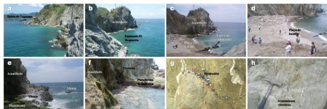
Figura 18. Rasgos geológicos en el Mirador de Punta Betín. (a-b) Zona acantilada. (c-d) Ensenada El Boquerón, playa de bolsillo y emisario submarino. (e) Acción del oleaje sobre el macizo rocoso y plataforma de abrasión. (f) Caverna. (g) Efecto de la bioerosión sobre el substrato rocoso. (h) Greenstones cloríticos. Fuente: Los autores.
