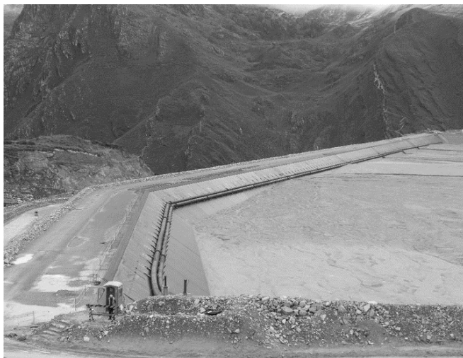
Figura 1. Presa de relaves Antamina, Perú, vista desde aguas arriba. Fuente: [16]
