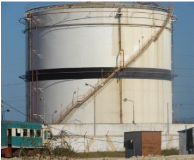
Figura 5. Tanque de combustible Fuente: Los autores.
