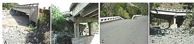
Figura 17. Afectaciones estructurales en puentes de la carretera Granma por efecto de erosión por socavación en los ríos que la atraviesan (Caoba, Sevilla, La Plata, entre otros de la vertiente sur). Fuente: Fotografías tomadas por los autores.
