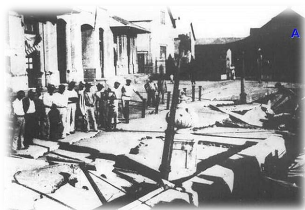
Figura 12. Afectaciones que se produjeron en la zona de la Alameda (Avenida Jesús Menéndez), en la ciudad de Santiago de Cuba durante el terremoto del 3 de febrero de 1932, causadas probablemente por la licuefacción del terreno.
