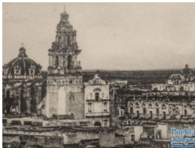
Figura 1 Torre original del templo de la Merced antes del año 1872. Fuente: Mercedarios Puebla.
