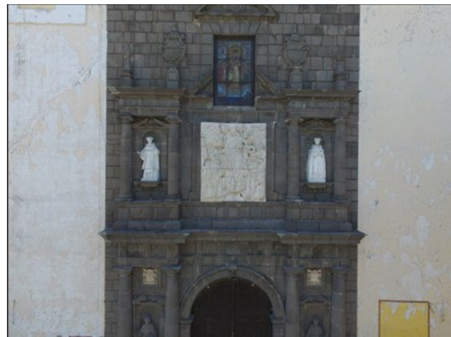
Figura 34. Levantamiento topográfico del exterior de la fachada. Fuente: Fotografía tomada por Cárdenas-López, 2023.
