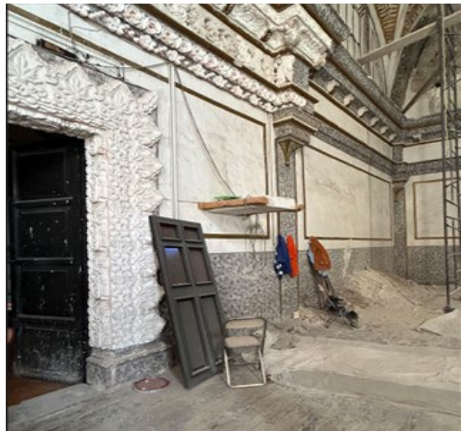
Figura 17. Sensor 2 instalado en la zona del coro. Fuente: Fotografía tomada por Cárdenas-López, 2023.
