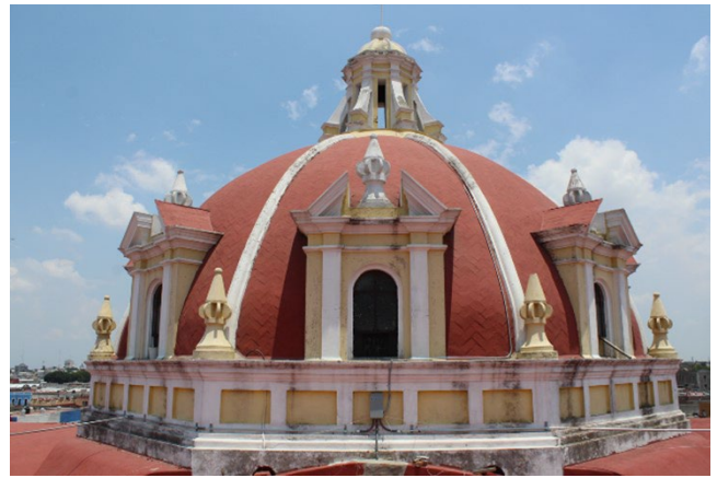
Figura 16. Sensor 1 instalado en el interior de la cúpula. Fuente: Fotografía tomada por Cárdenas-López, 2023.
