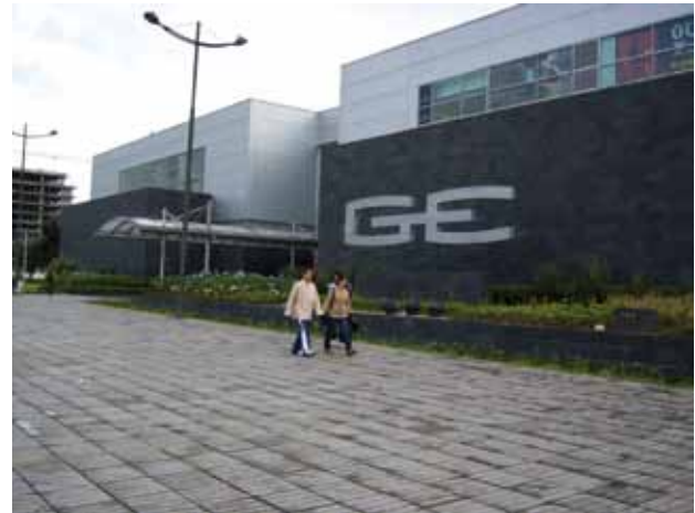
Figura 11. Fachada de Gran Estación.
