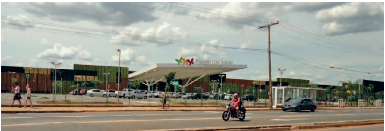
Figura 4. Fachada do Shopping vista pela Avenida Perimetral Norte. Fotografia das autoras, novembro 2014.
