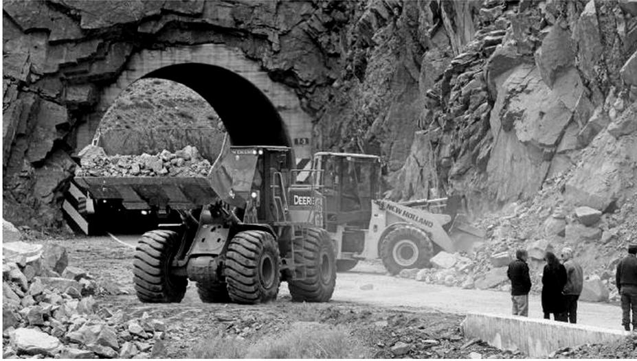
**Figura 10.** Máquinas viales despejando la caída de bloques del Túnel n.º 3 de la Ruta Internacional n.º 7, originada el 14 de noviembre del 2011 por lluvias intensas durante 2 días.
