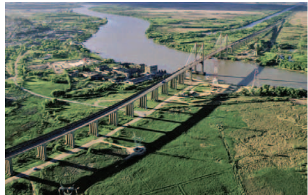
Figura 9. Vista de Zárate y del puente Brazo Largo. Fotografía de A. Martín 2009.
