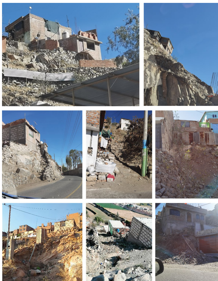
Figura 17. Unidades de hábitat en pendiente: escaleras, muros de contención, aterrazamientos y tuberías expuestas. Fotografías de Gutiérrez, noviembre de 2022.
