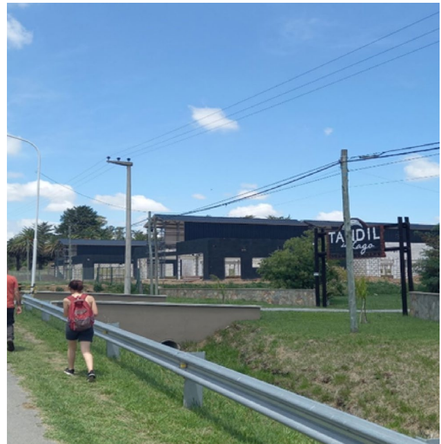
Figuras 7. Locales comerciales expuestos a la depresión relativa y alcantarillas con diámetro reducido. Fotografía de Lapena, noviembre de 2022.
