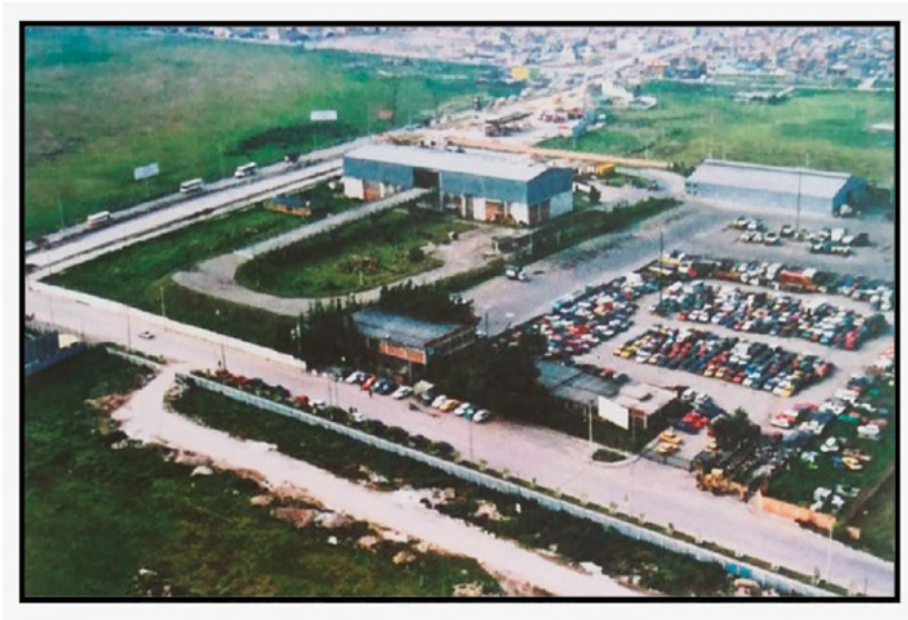
Figura 6. Planta de transferencia de Protecho
