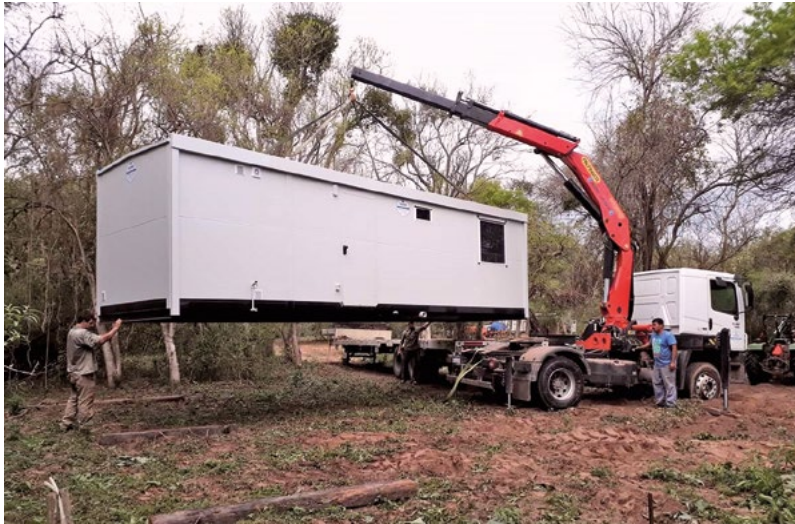
Figura 6. Módulos habitacionales instalados en septiembre del 2018
