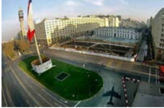
Figura 10. Palacio de La Moneda e intervención de aviones
