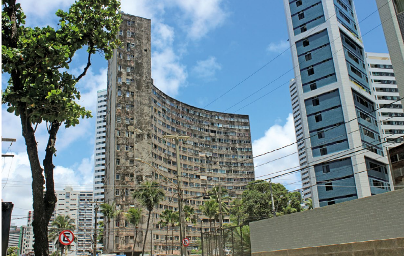
Figura 5. Edificio Holiday, 19 de febrero del 2019, 11h03
