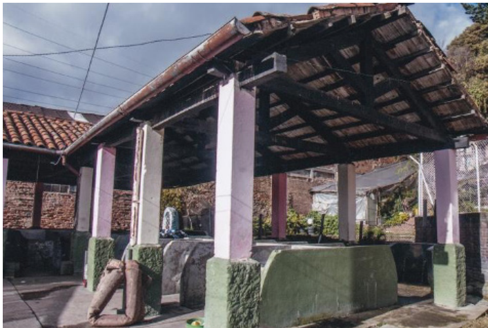
Figura 4. Estructura de la cubierta de la zona de los lavaderos
