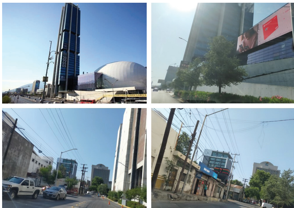
Figura 1. Contradicciones urbanas: el moderno Pabellón M y su contexto
