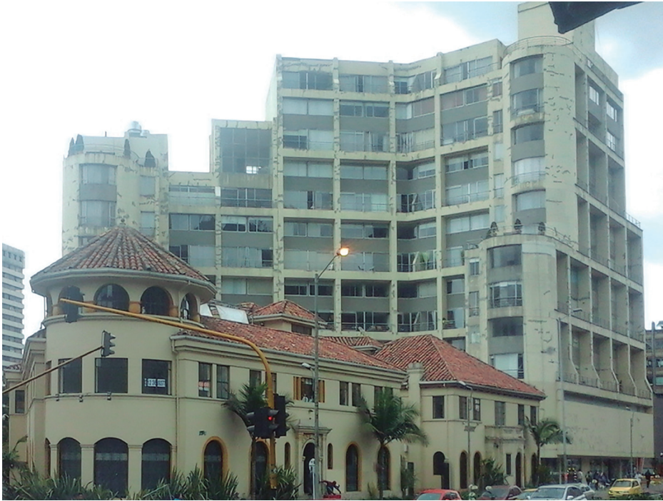
Figura 1. Edificio Baraglia-Plaza 39 de Bogotá, Colombia
