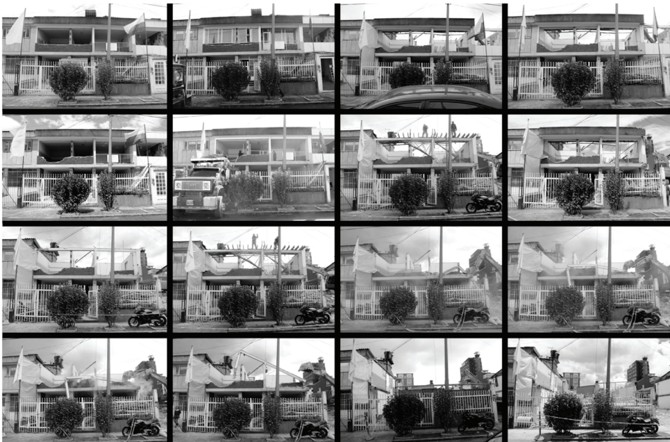
Figura 2. Secuencia de una demolición de una vivienda en Bogotá
