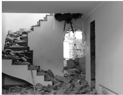
Figura 1. Demolición de una casa cualquiera en Bogotá
