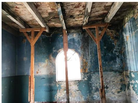
Son evidentes la presencia de humedad en la losa de entortado y el flechamiento de las vigas de madera.
